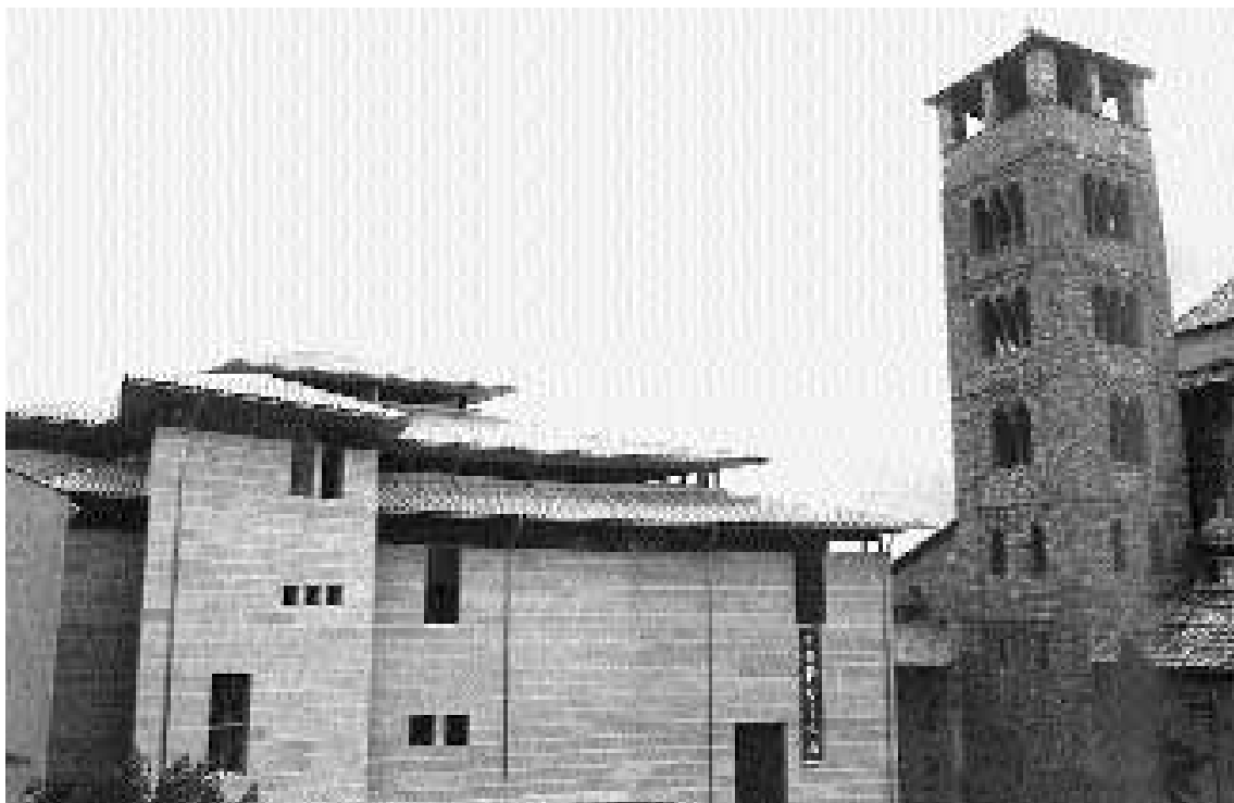
Obres del Nou Museu Episcopal.
