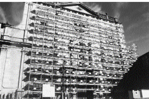
Restauració de la façana de la Catedral.
